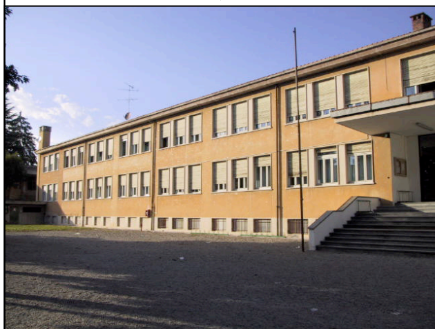
2 Edificio scolastico veduta generale
