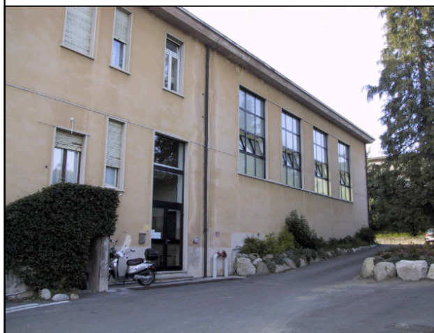
3 Edificio scolastico ingresso segreteria e palestra
